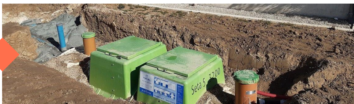
Installation d'ANC chez un particulier - Source : SATESE 37
