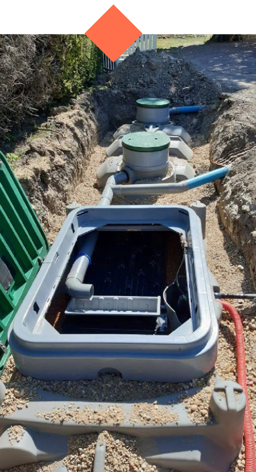
Installation d'ANC chez un particulier Source : SATESE 37
