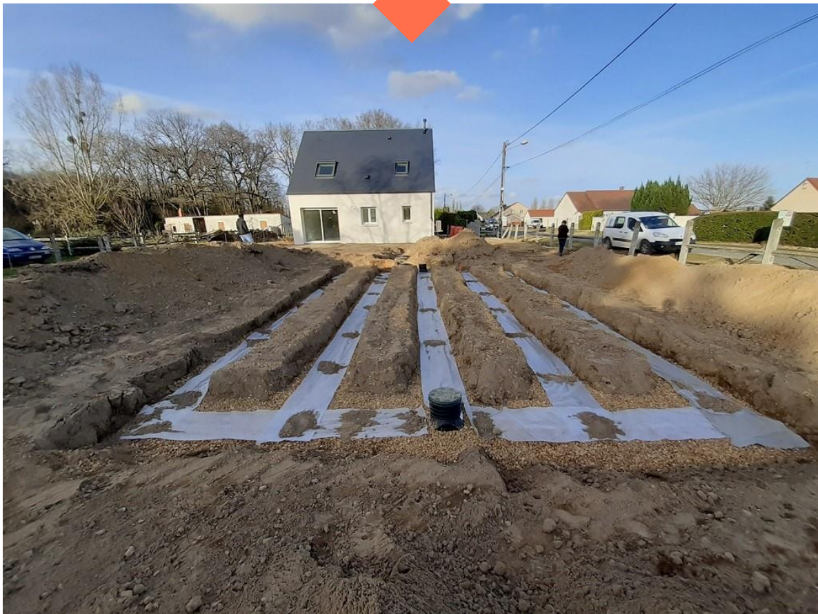
Installation d'ANC chez un particulier - Source : SATESE 37
